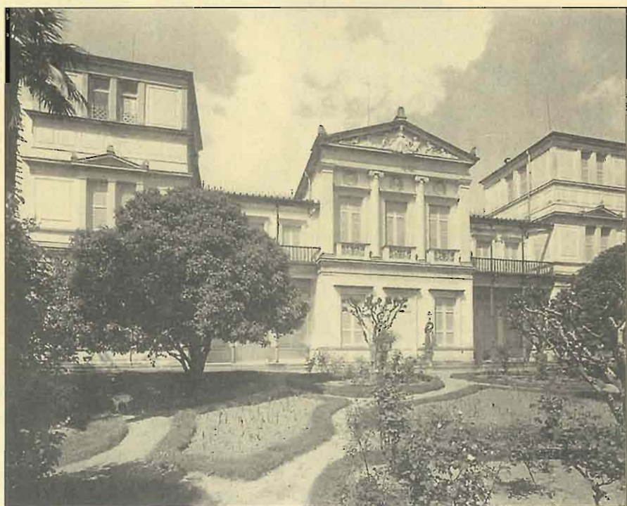
Fronte sud, verso Lugano, del Castello di Trevano (demolito nel 1961; le "torche- res" sono scomparse).
