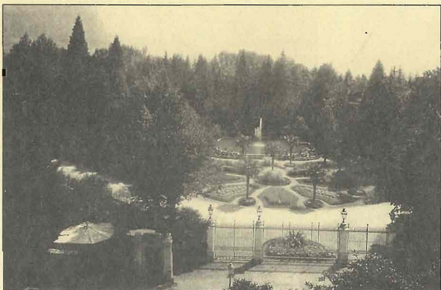
Entrata al parco di Trevano (oggi il giardino è stato trasformato in posteggi).
